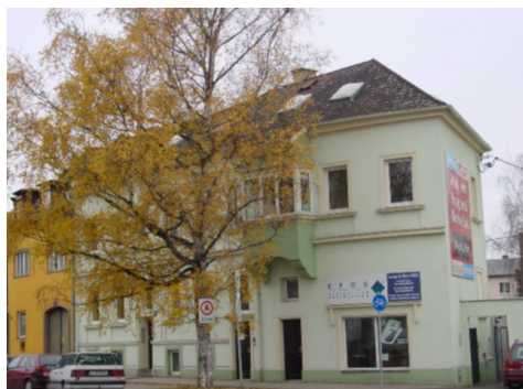
Ansicht des Gebäudes
